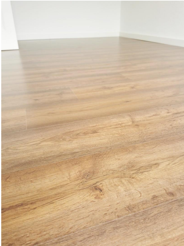
Laminat, 2023 neu verlegt
