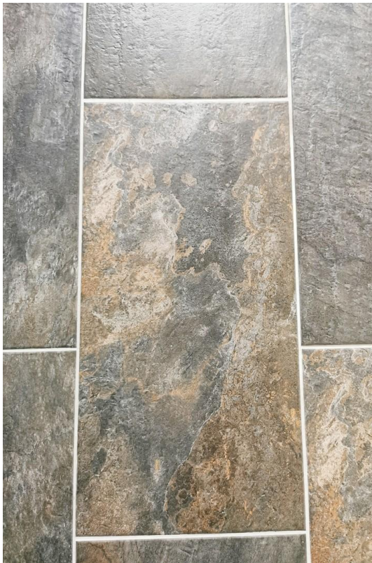
Bodenfliesen, 2023 neu verlegt
