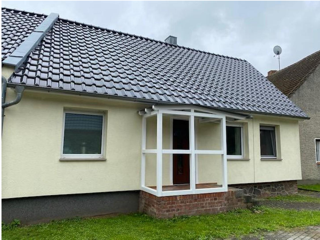
Eingang mit Parkplatz
