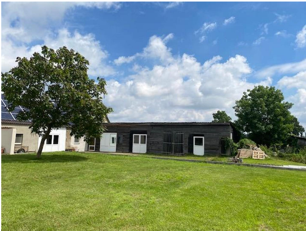
Blick vom Backhaus
