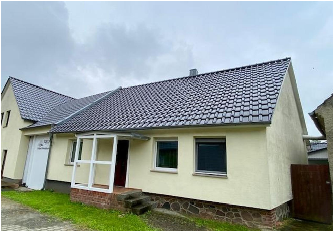
Haus 2 eigener Eingang
