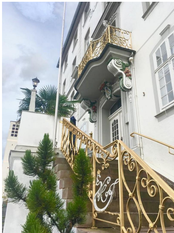
Eingangstreppe mit Balkon
