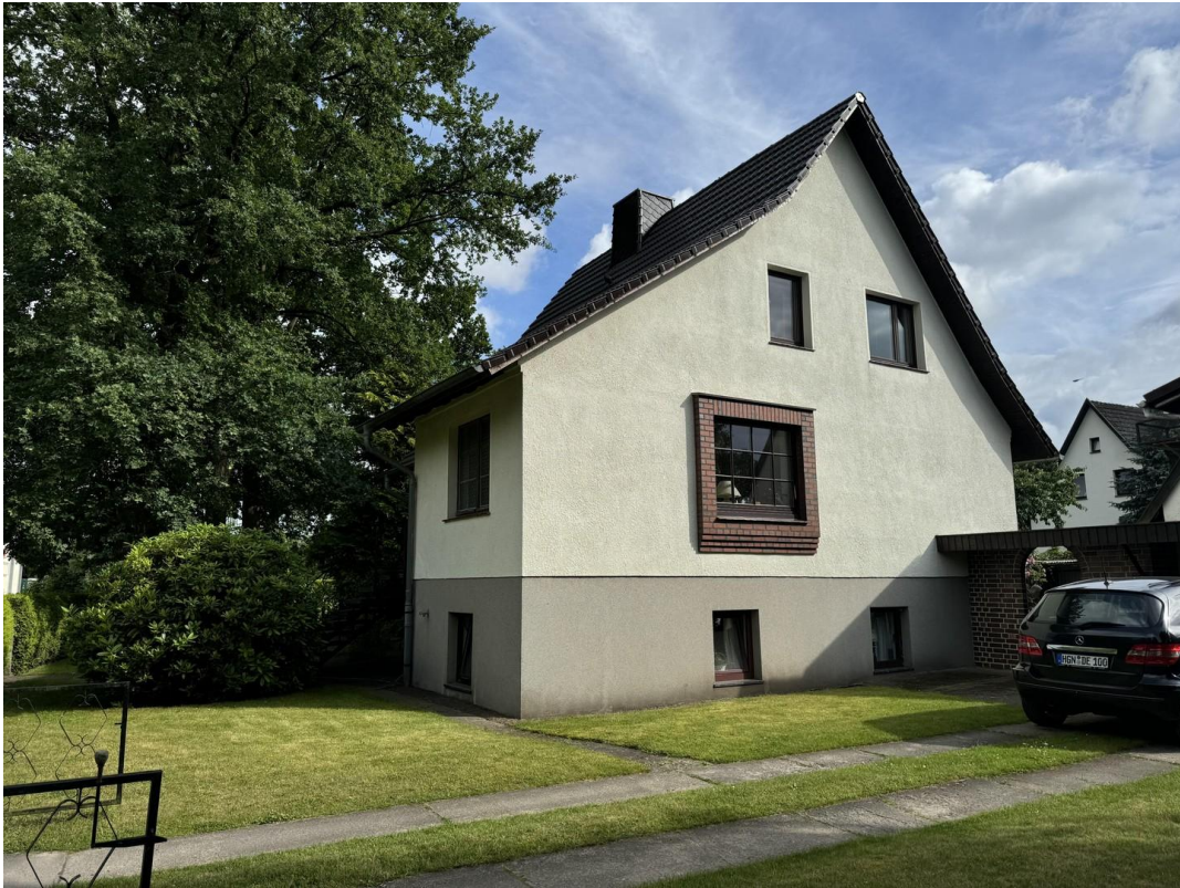
Seitenansicht mit Einfahrt
