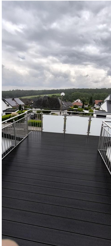
Blick von Dachterrasse
