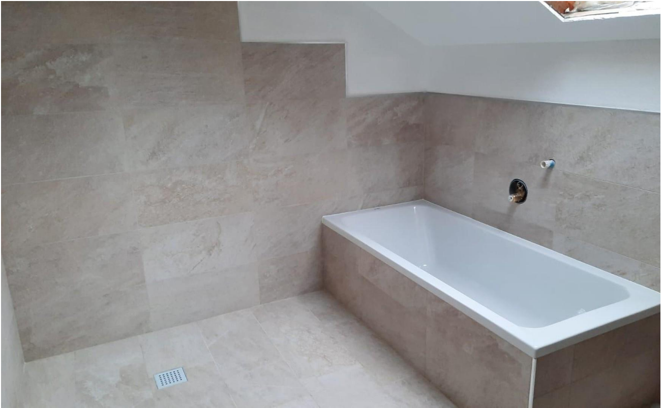
OG Bad nach Renovierung
