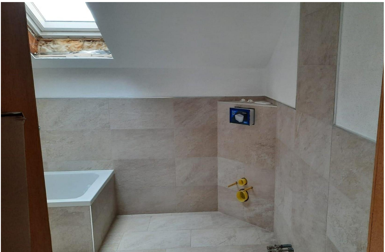
OG Bad nach Renovierung
