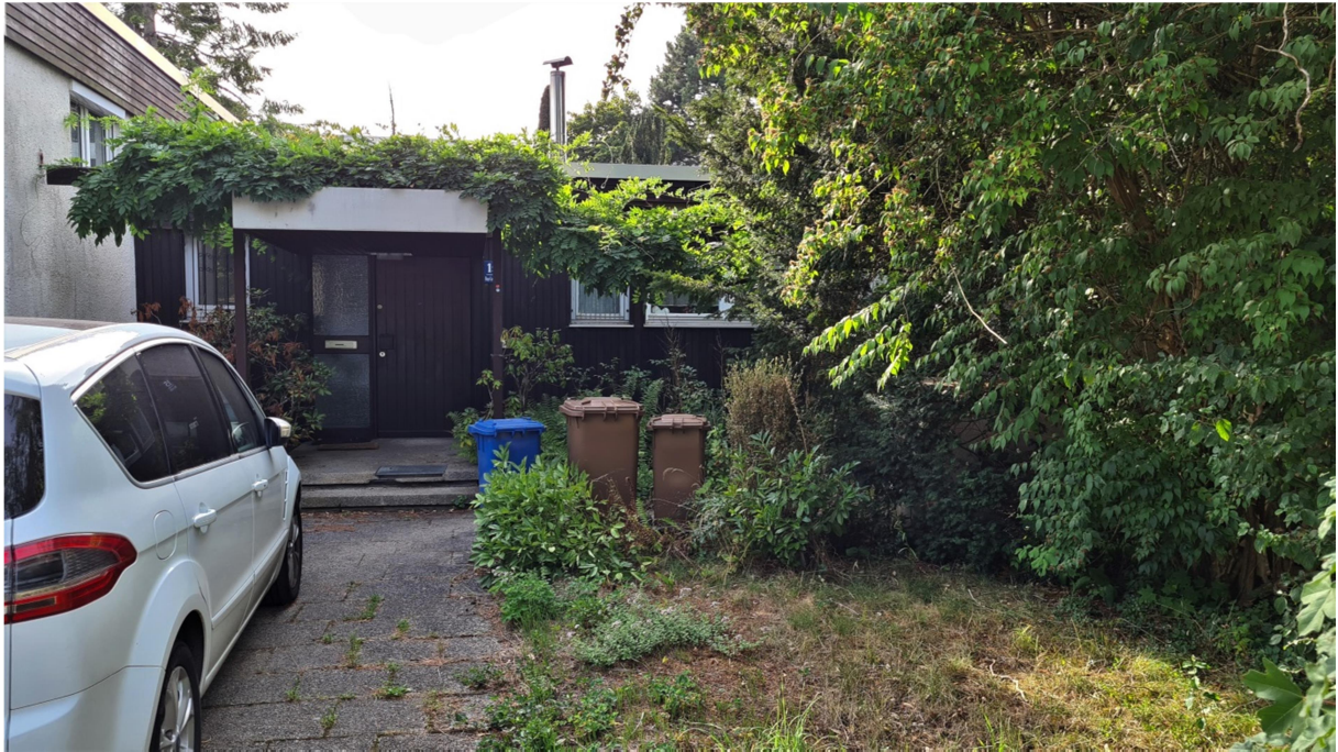
Der überdachte Eingangsbereich aus dem Vorgarten betrachtet
