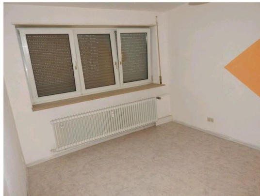
Detailansicht Boden-, Wandbeläge, Fenster, Heizkörper
