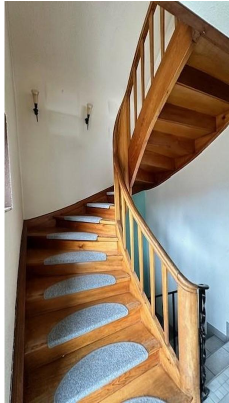
Holztreppe ins Dachgeschoss
