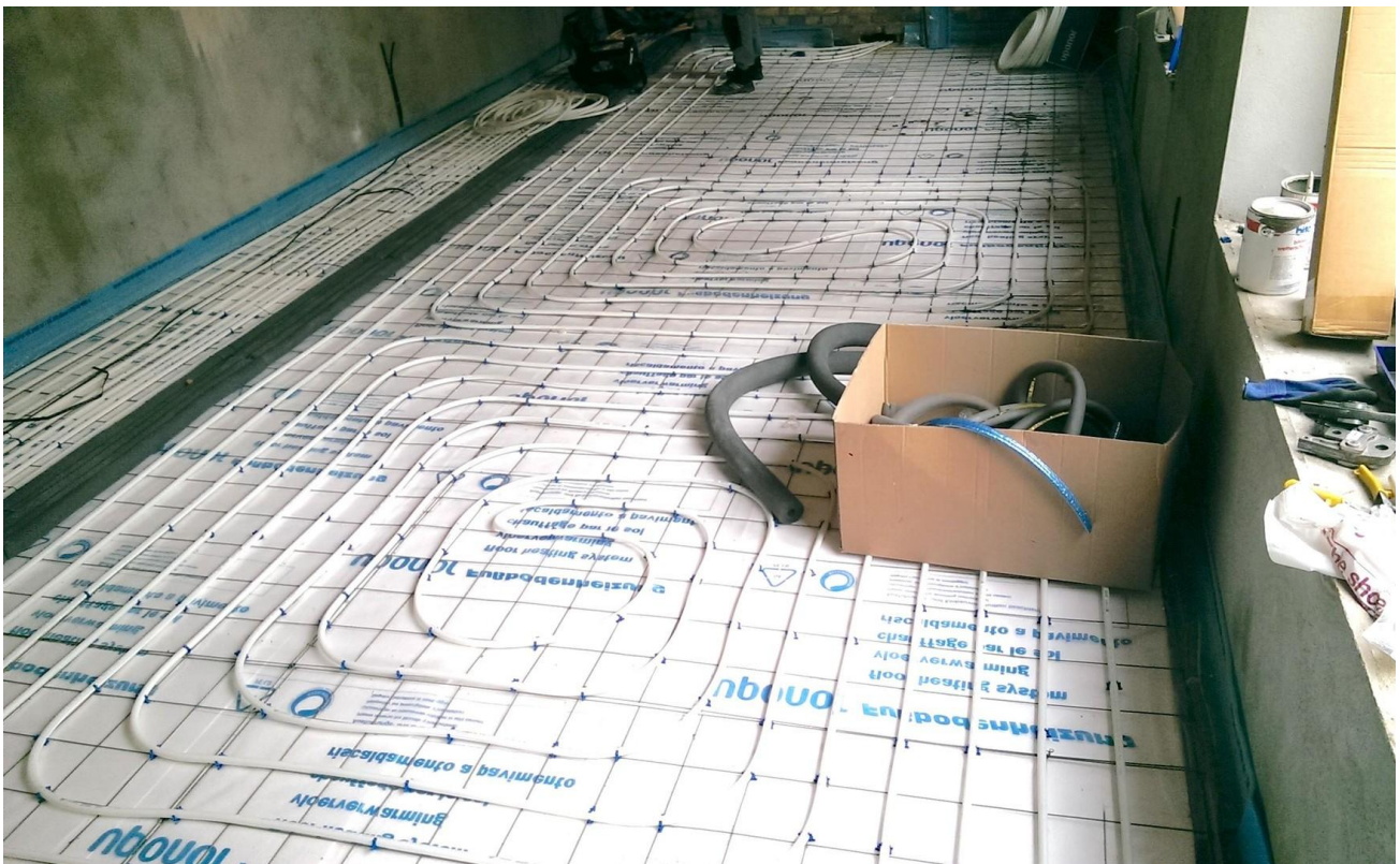
Bauphase Fußbodenheizung
