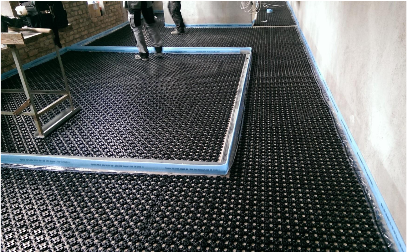
Bauphase Fußbodenheizung
