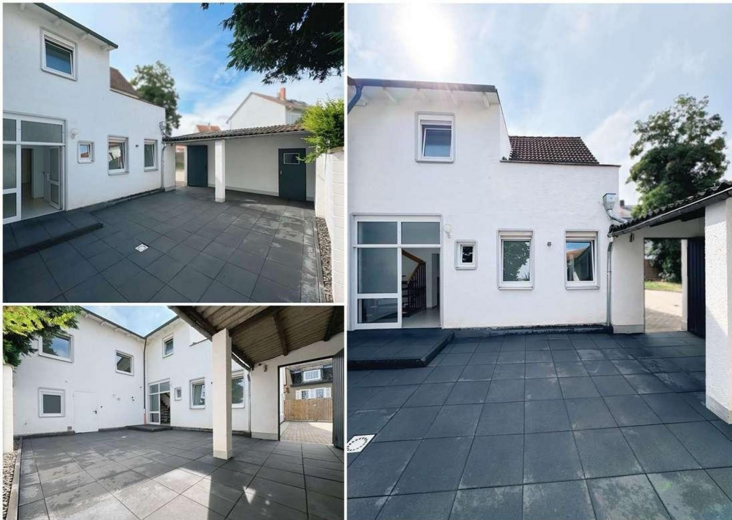
Innenhof / Atrium/ Hauseingang
