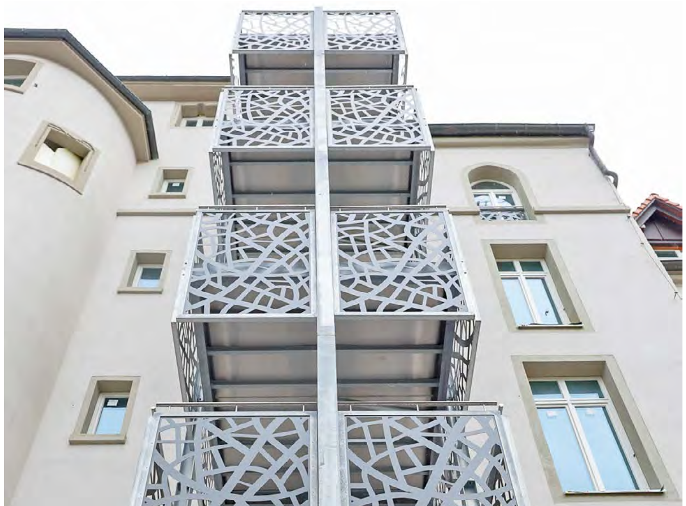
Ein Großteil der Wohnungen zum Hof hin gelegen hat großzügige Balkone
