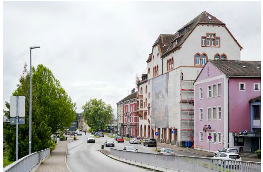
Die historische Fassade hier noch mit Gerüst
