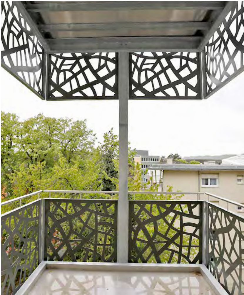
Balkone zum Innenhof
