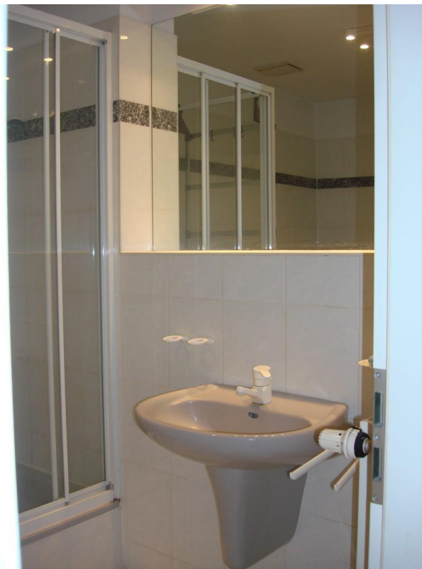
Waschbecken mit Halbsäule
