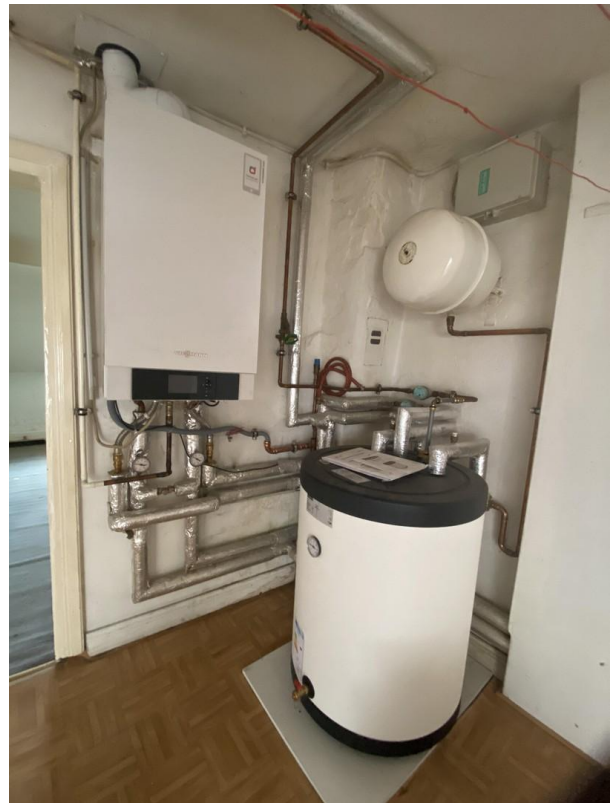
Gasheizung/Warmwasserspeicher
