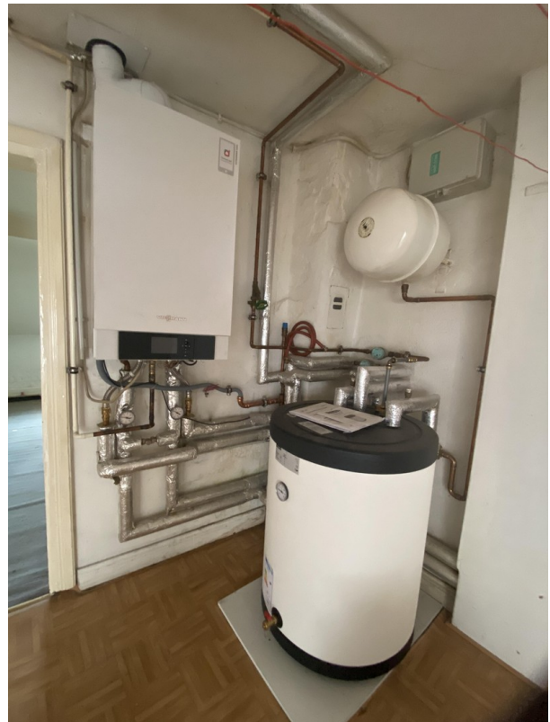
Gasheizung/Warmwasserspeicher
