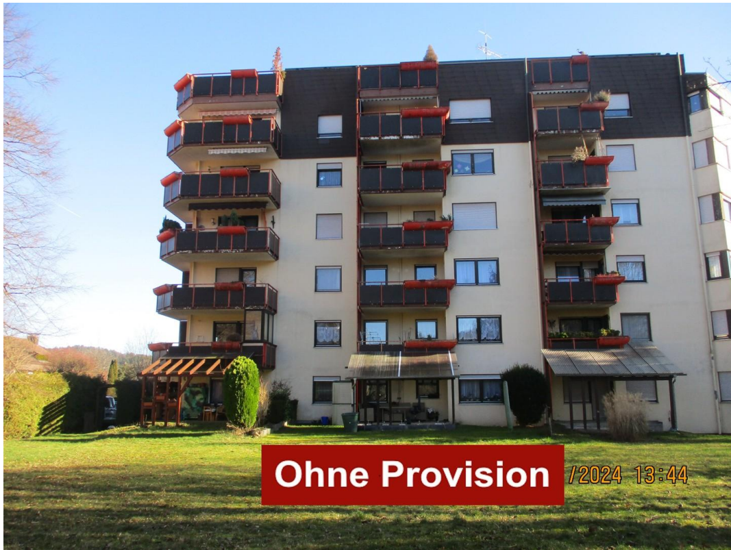
Hausansicht mit Balkon
