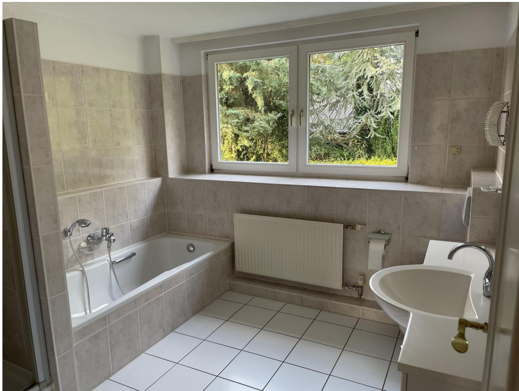
Bad mit Dusche, erstes OG
