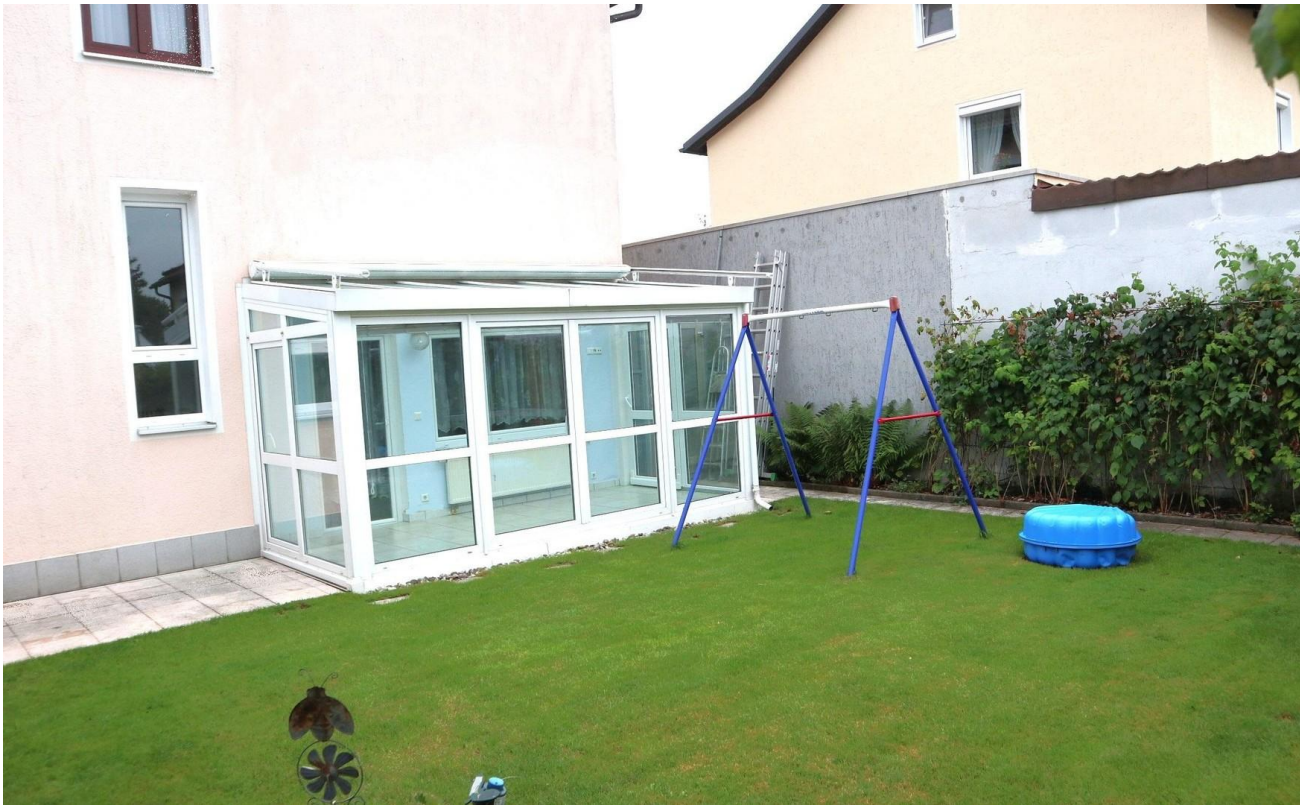
Nordseite mit Wintergarten
