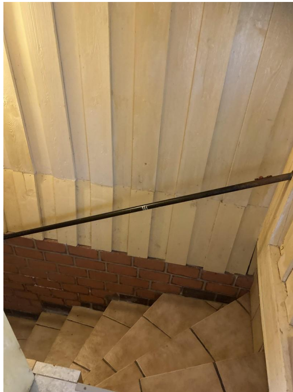
Treppe zum Keller
