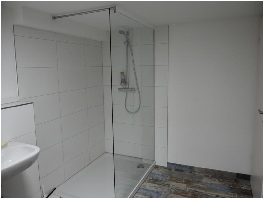
Grosse Dusche 1,4m im Keller
