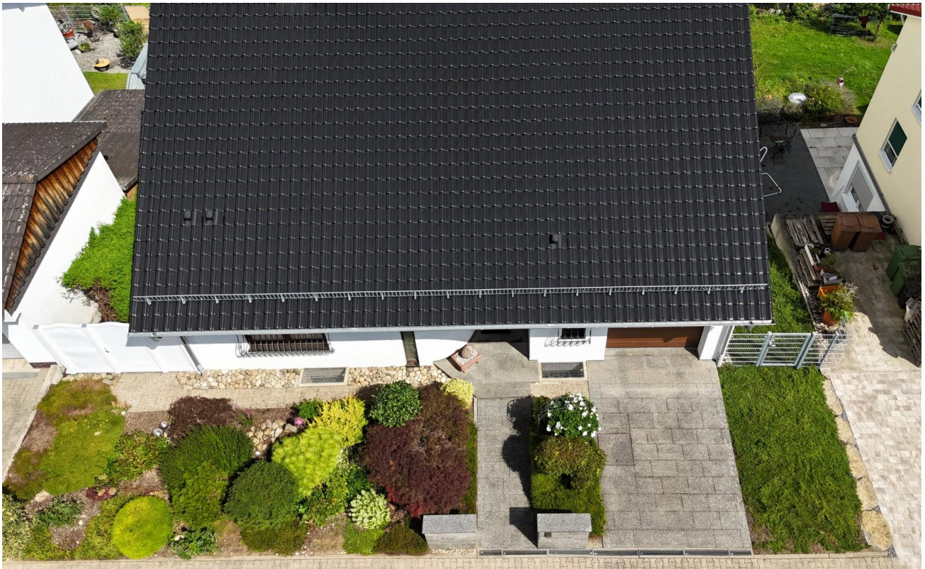
Dach neu gedeckt & isoliert 22
