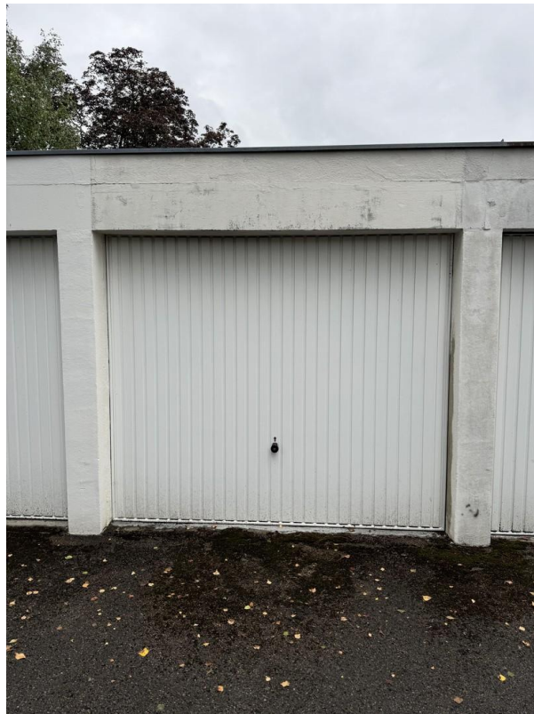
Garage im Garagenhof
