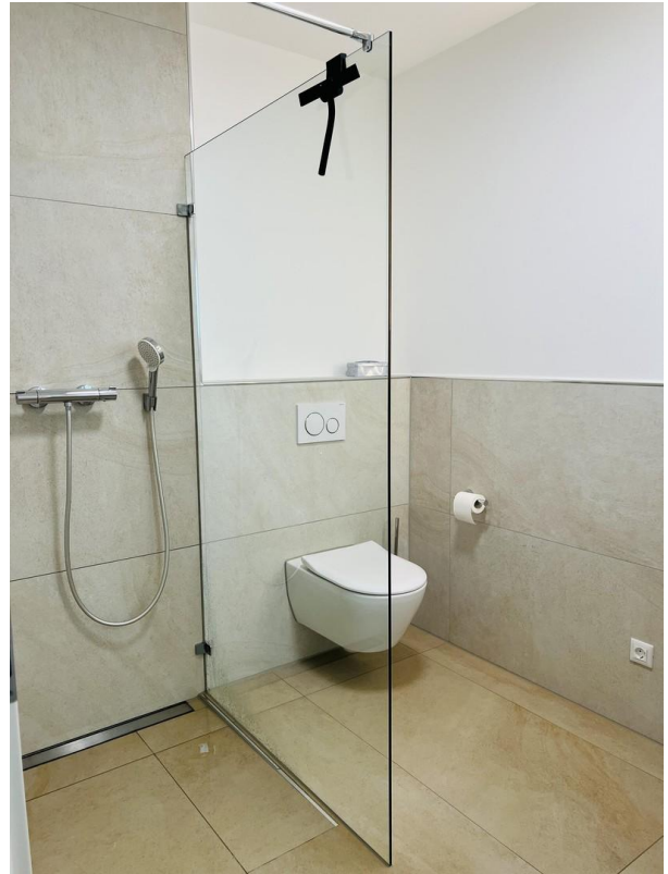
EG Bad Dusche WC
