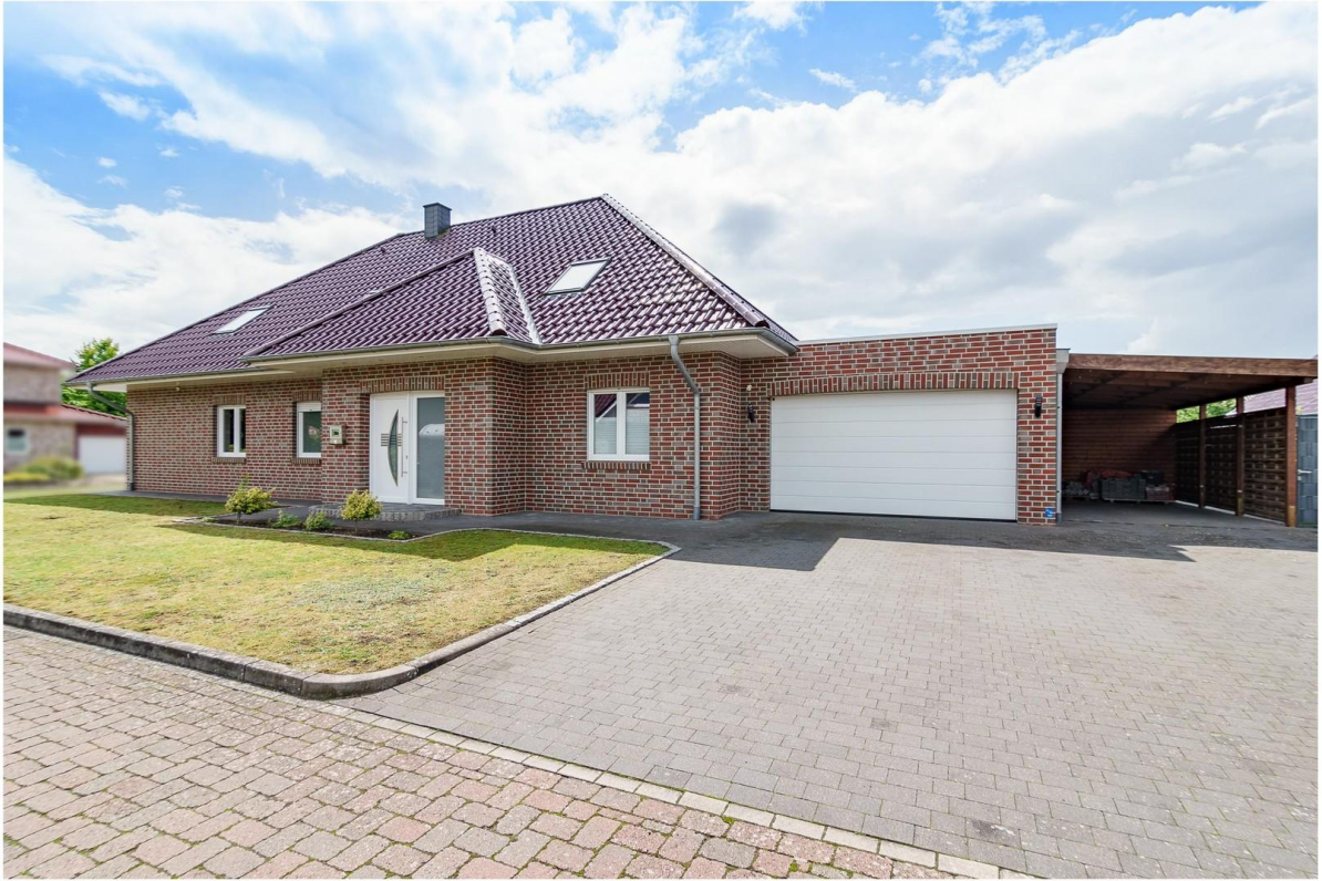
Einfahrt / Garage / Carport
