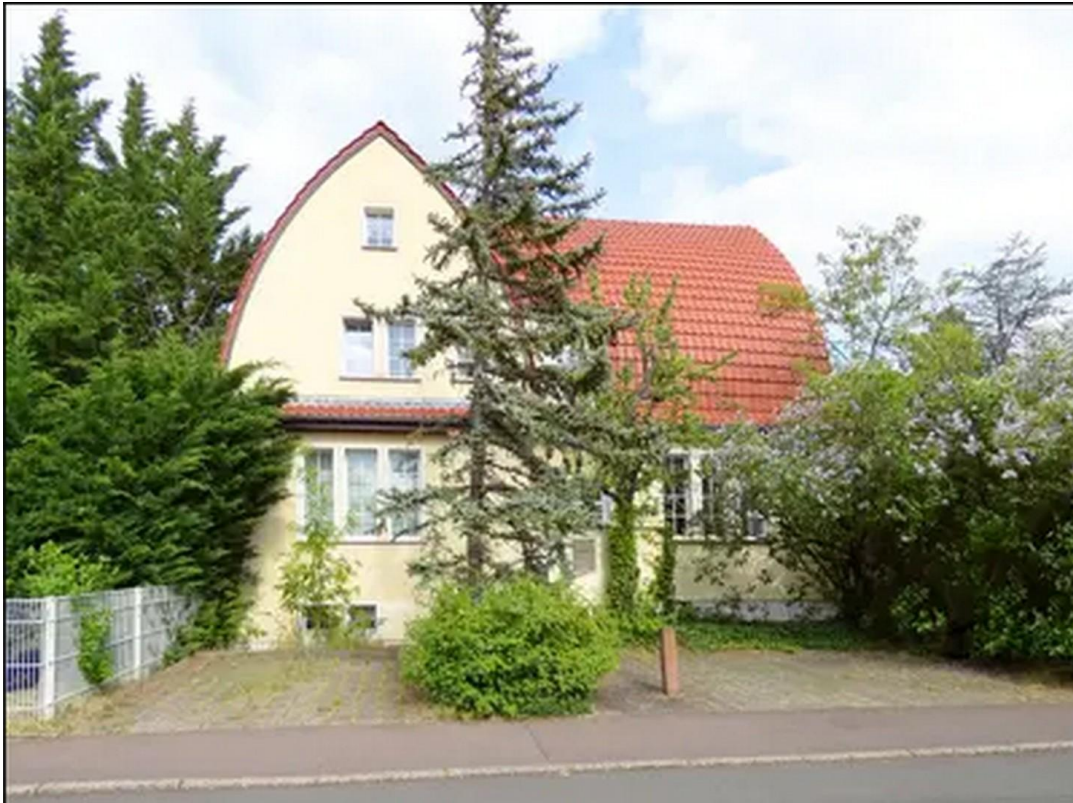
Westseite, Eingang Kanzlei
