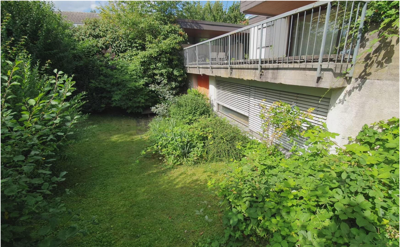
Westansicht Fenster UG
