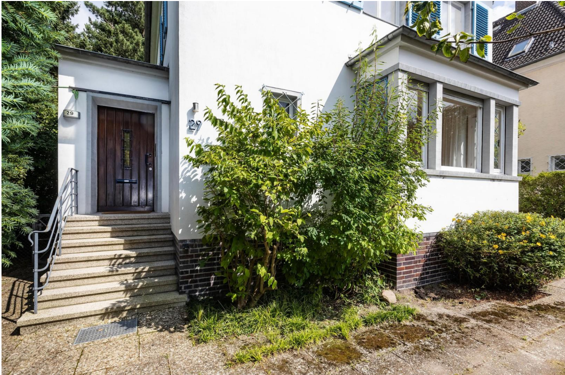
Ansicht von der Straße, Detail
