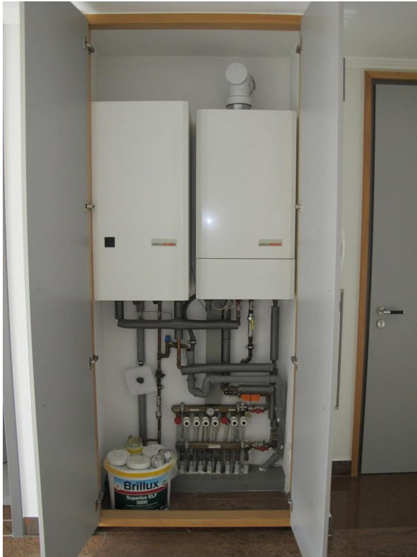
Gas-Brennwertheizung
