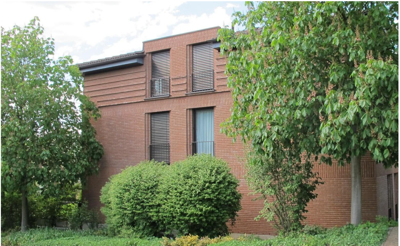
Außenansicht Haus 35/35a
