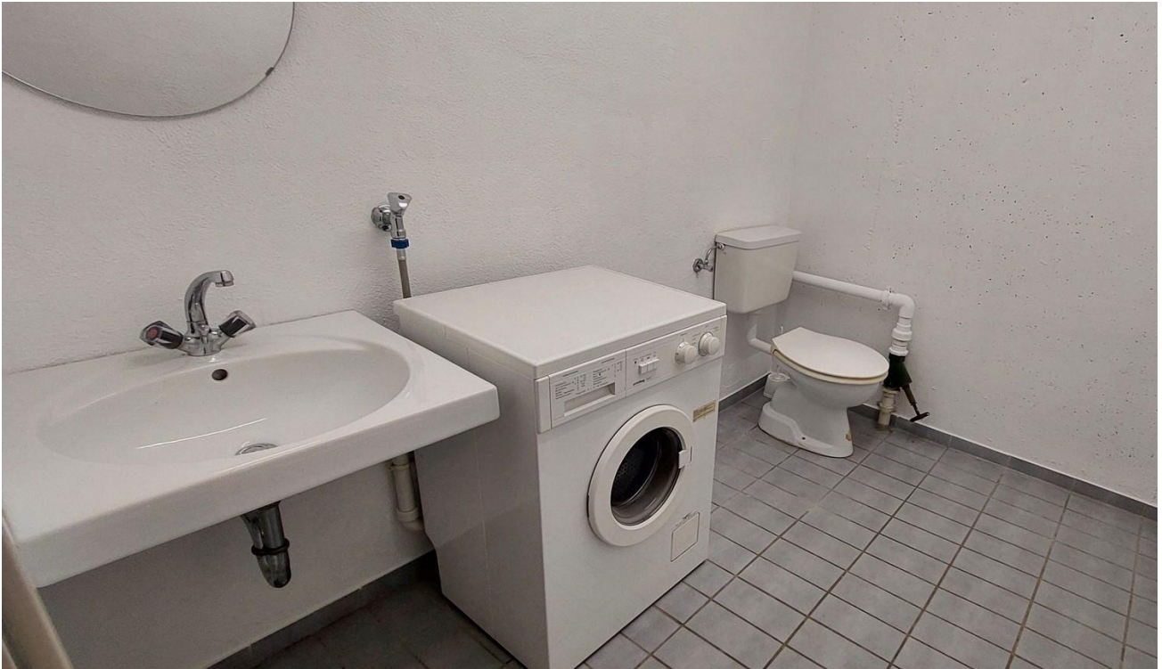
Waschküche mit WC
