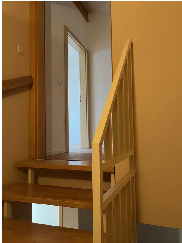
Treppe zum ausgeb. Speicher
