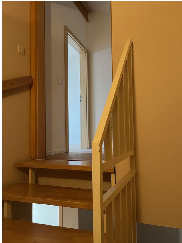
Treppe zum ausgeb. Speicher
