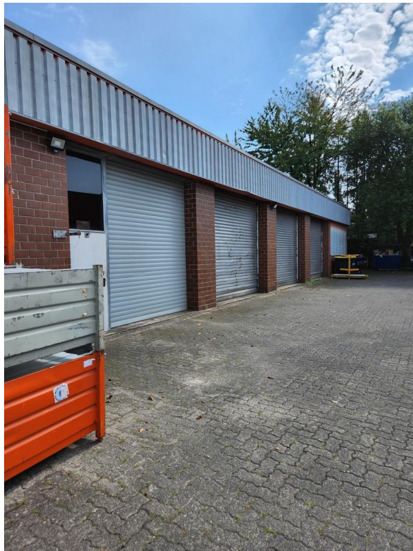
Rolltore in der Kalthalle
