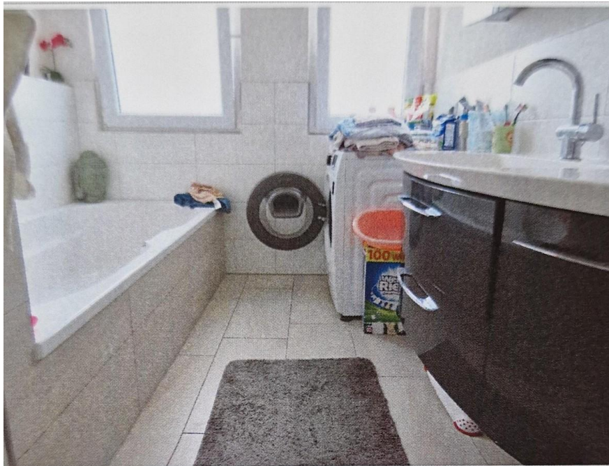
Ausbau der Wohnung Nr. 3 Badezimmer
