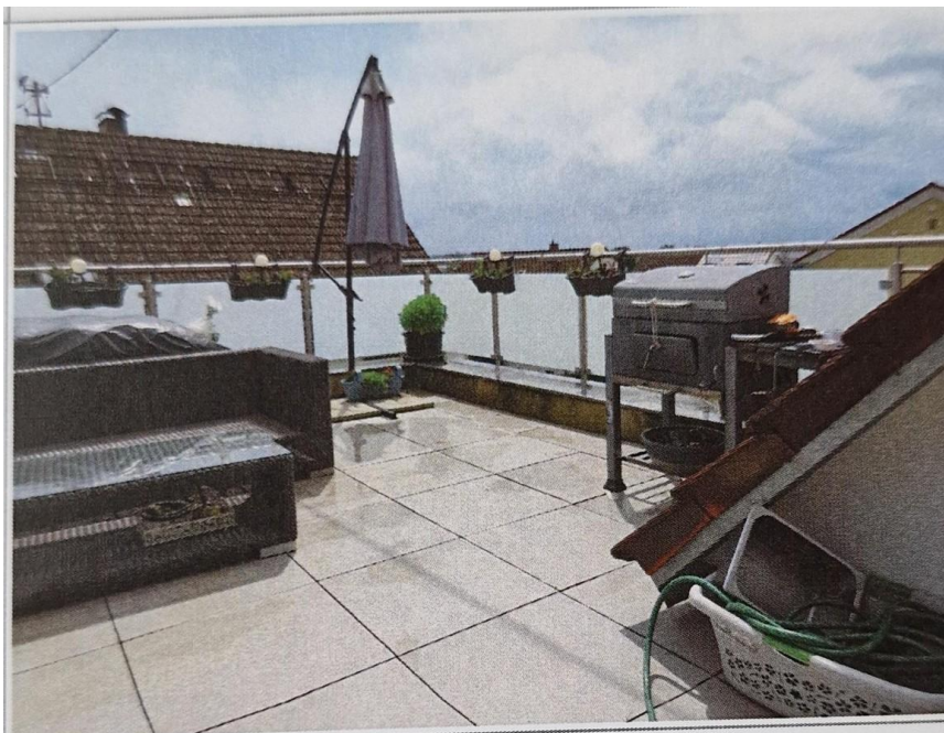
Ausbau der Wohnung Nr. 3 Ausbau der Dachterrasse Ost
