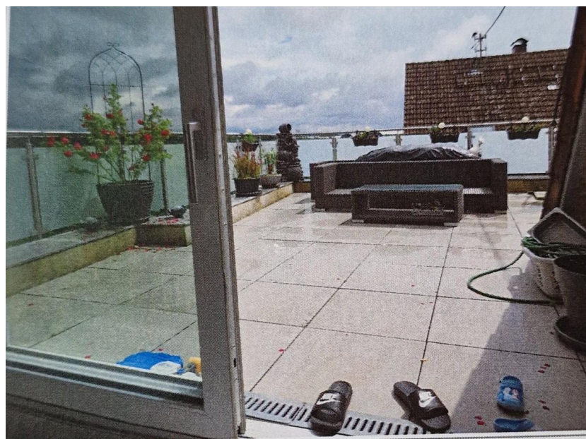
Ausbau der Wohnung Nr. 3 Zugang zur Dachterrasse Ost
