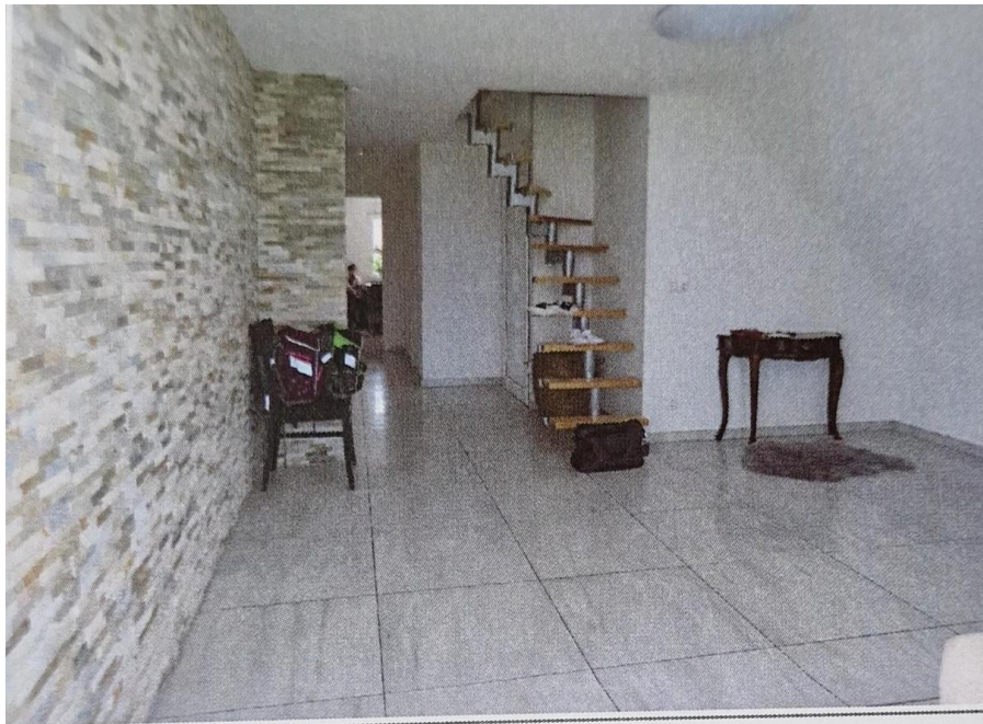
Ausbau der Wohnung Nr. 3 Wohnraumbereich
