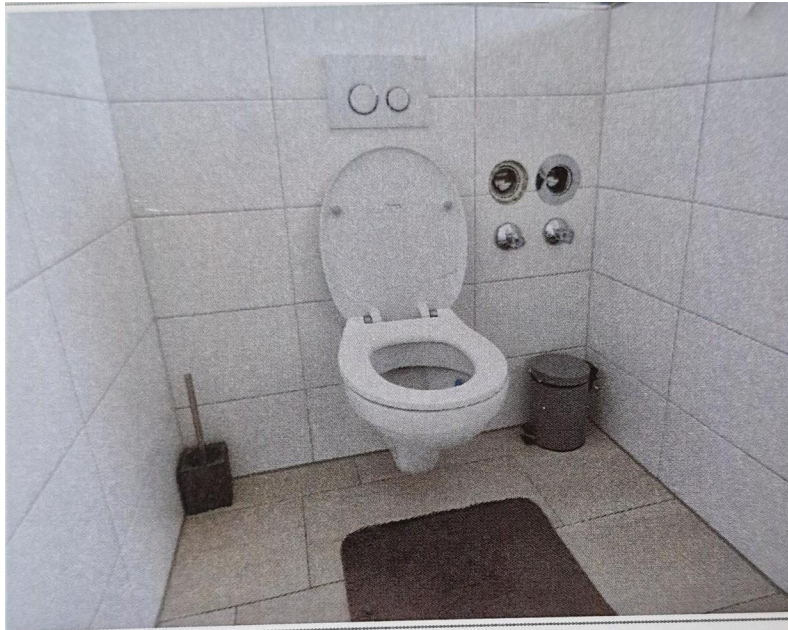
Ausbau der Wohnung Nr. 3 WC
