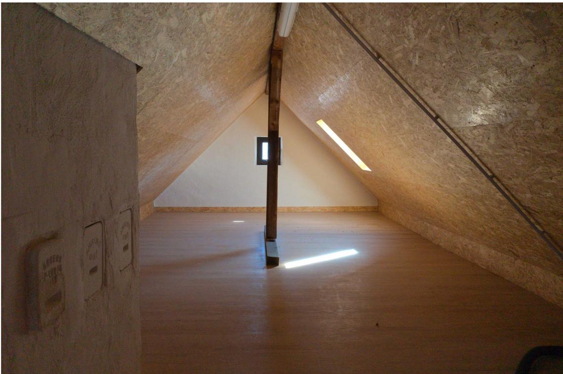
*Ausgebauter und gedämmter Spitzboden*
