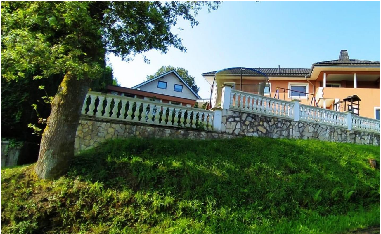
Ansicht auf das gesamte Haus
