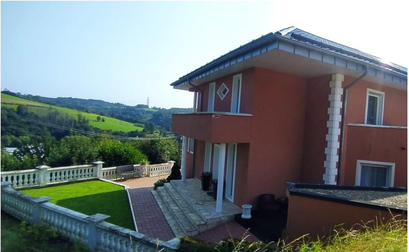
Überdachter Eingang Haus 2
