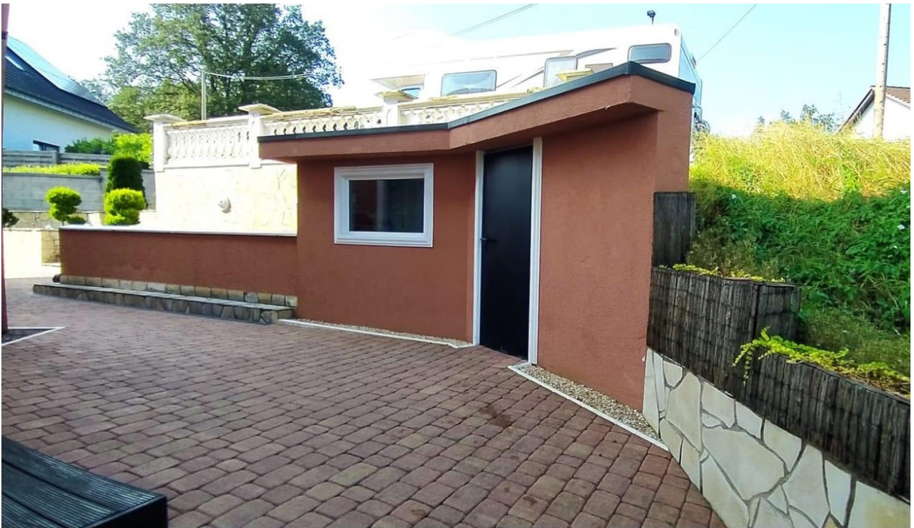
Gartenhaus 1 Massiv Gedämmt
