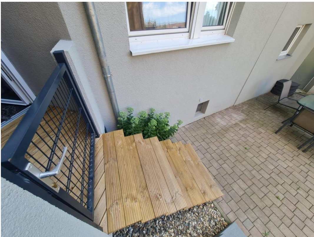
Balkontreppe EG links
