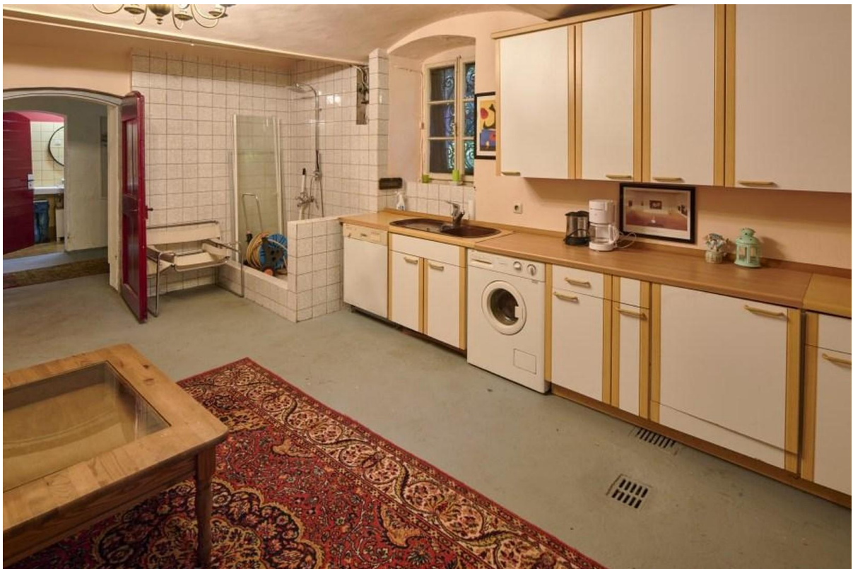
Küche / Waschküche im Keller
