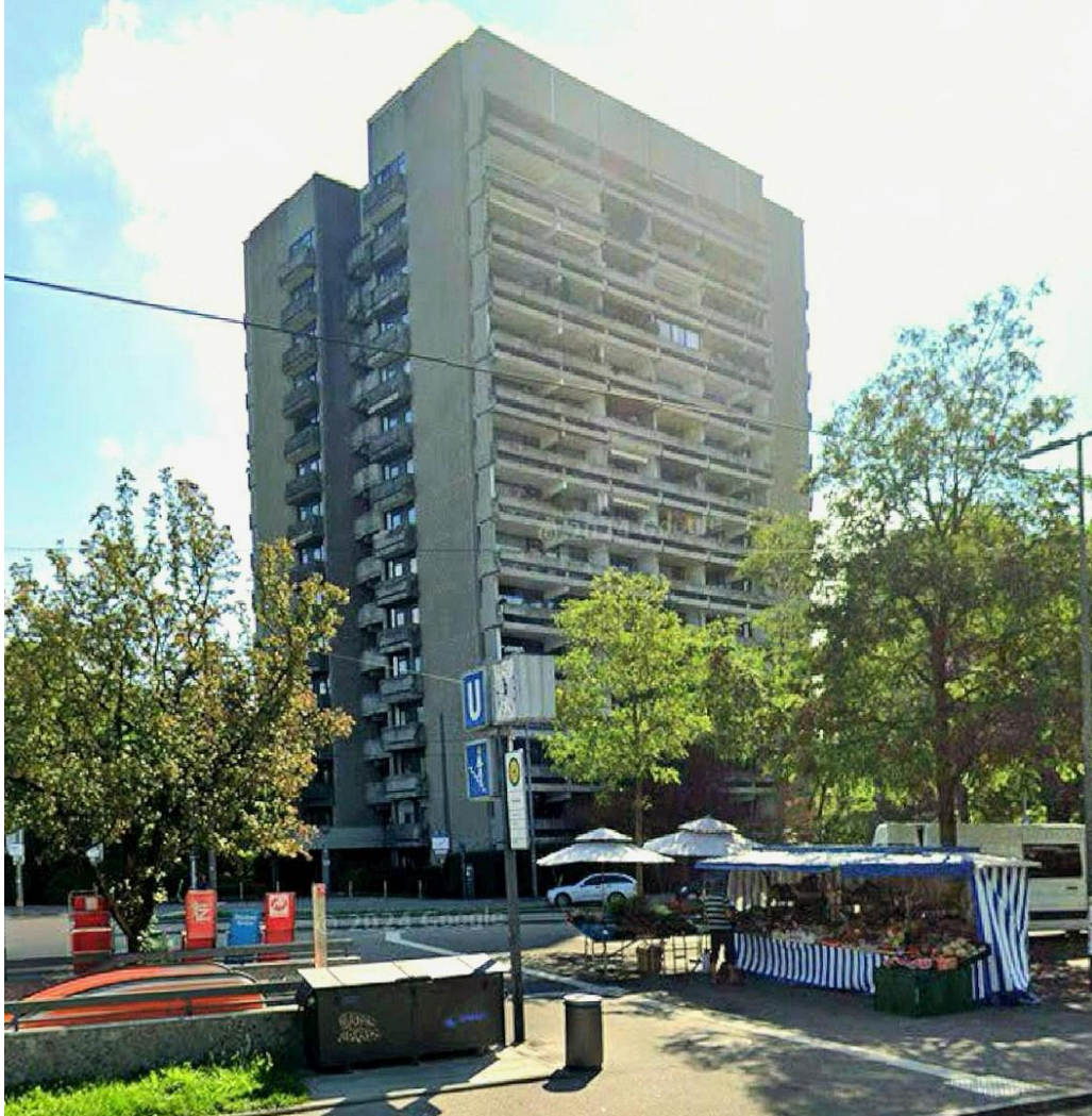
Gebäude Westseite; Whg im3.OG
