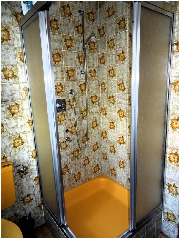
Duschbad Erdgeschoss Blick2
