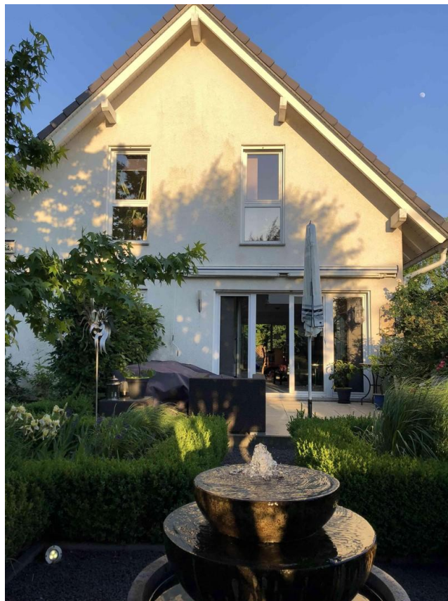
Westseite des Hauses
