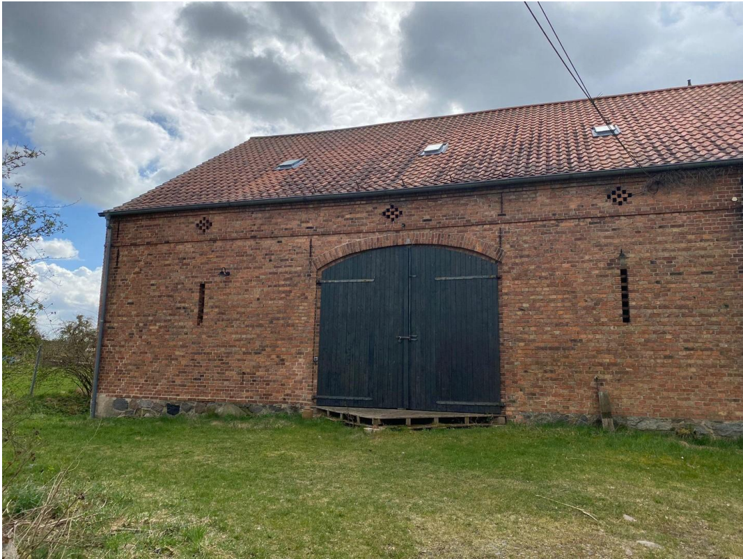
Blick vom Hof auf Scheune
