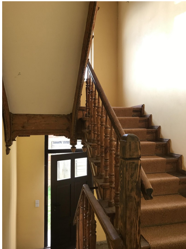
Treppenhaus zum DG
