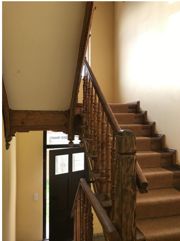
Treppenhaus zum DG
