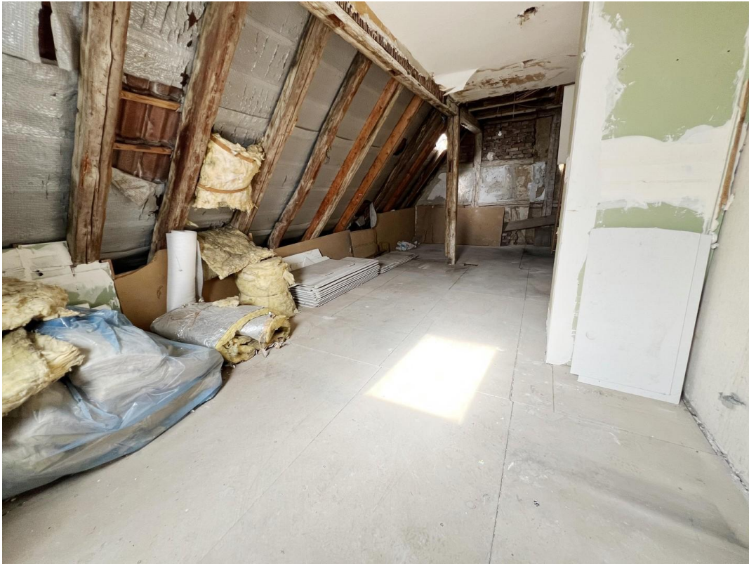
Mehrzweckraum - ausbaufähig D
