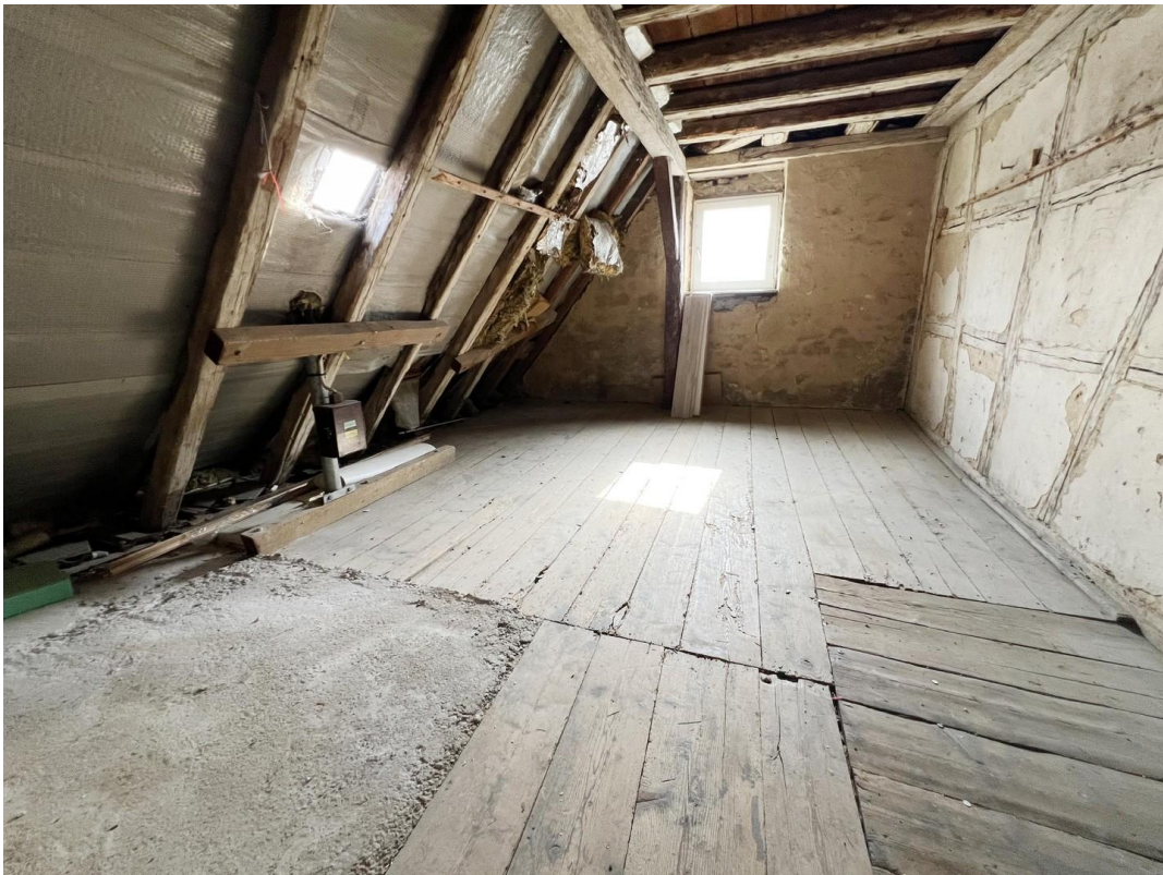
Mehrzweckraum - ausbaufähig D
