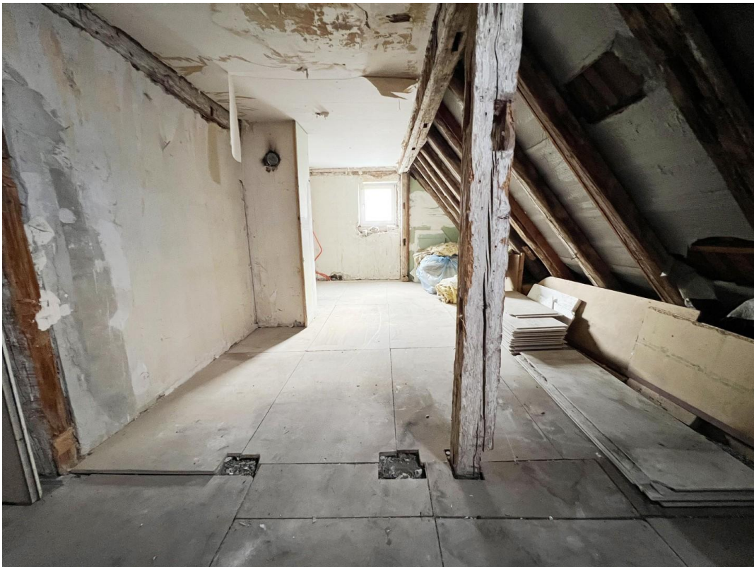
Mehrzweckraum - ausbaufähig D
