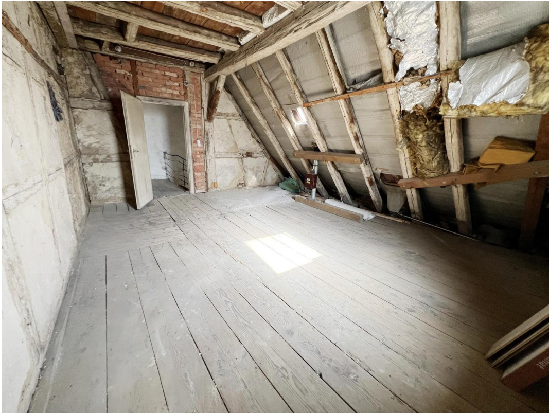
Mehrzweckraum - ausbaufähig D
