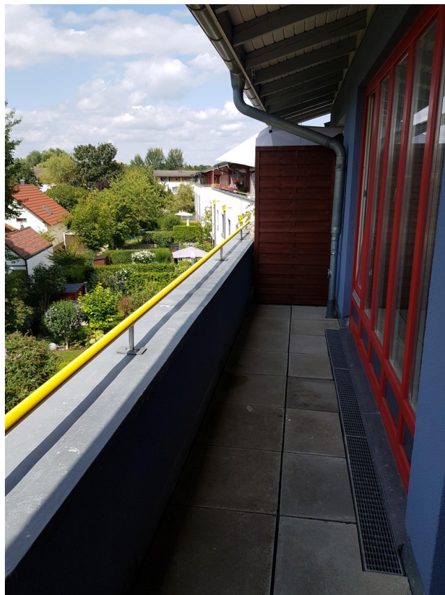
Blick von Dach-Terrasse 1
