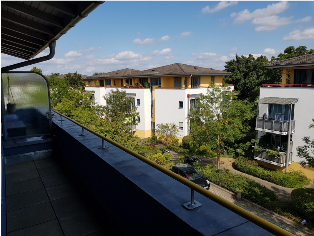
Blick von Dach-Terrasse 2
