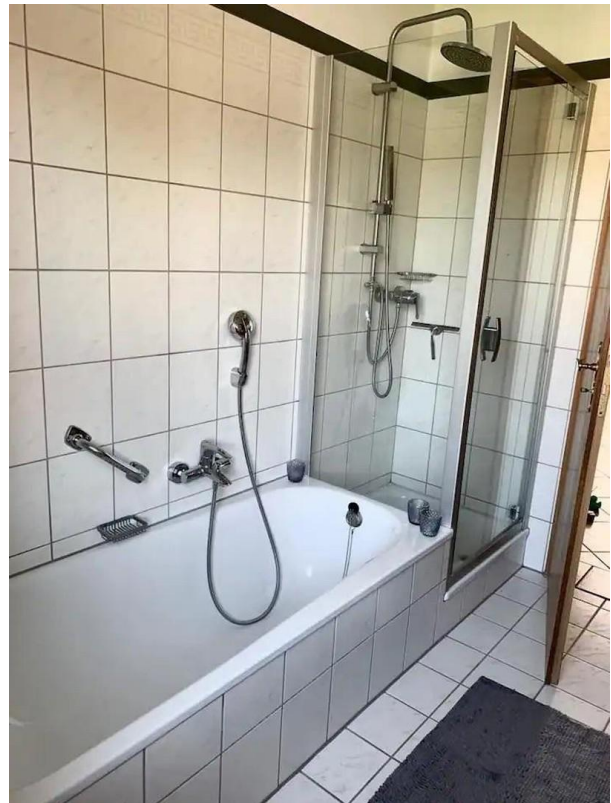
Bad EG Wohnung 2
