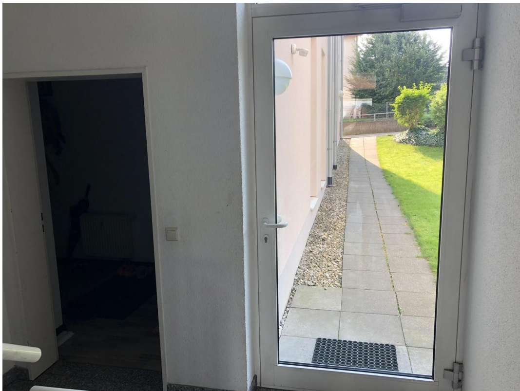
Hintertür direkt neben Wohnung
