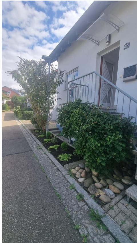
Aufgang zum Haupteingang EG
