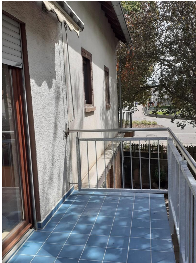
Balkon über Garage
