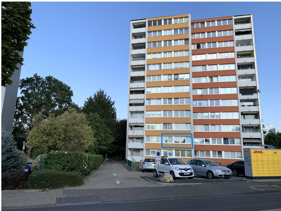
Hausansicht von der Straße
