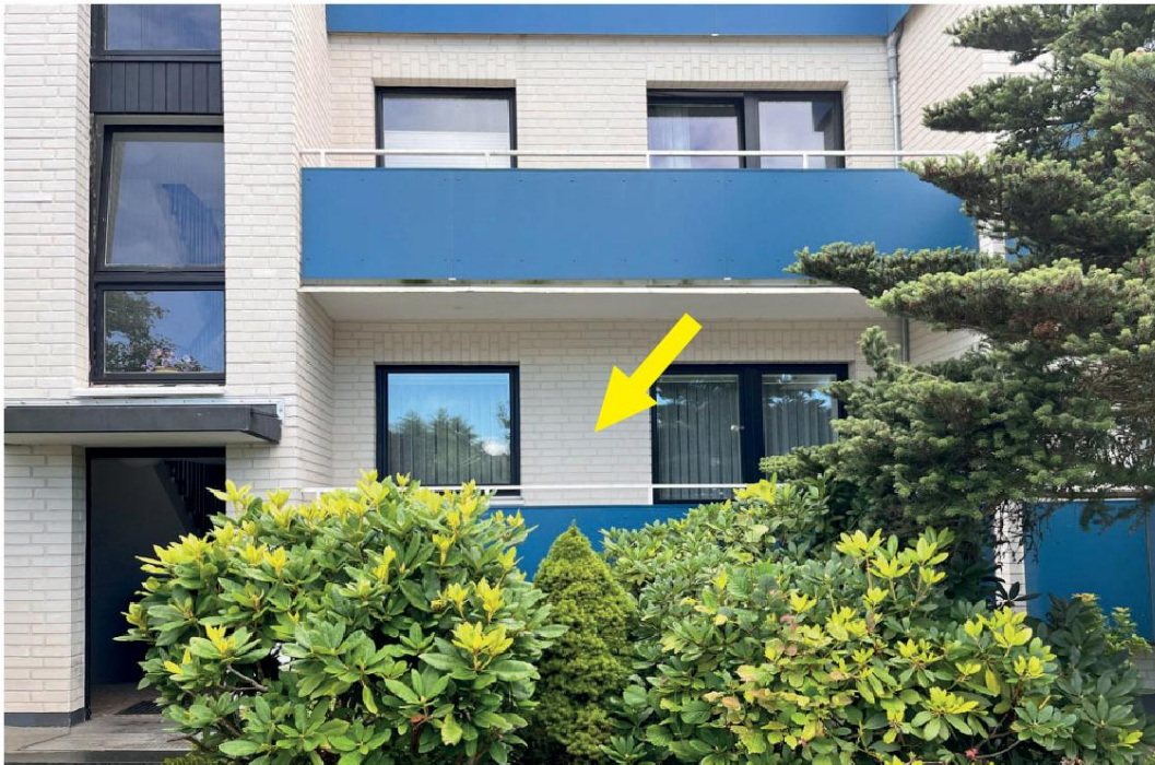
Hausvorderseite mit Loggia
