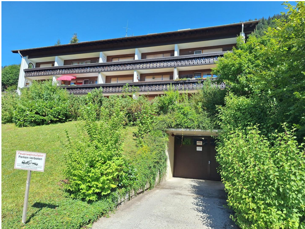
Südseite Gebäude mit TG
