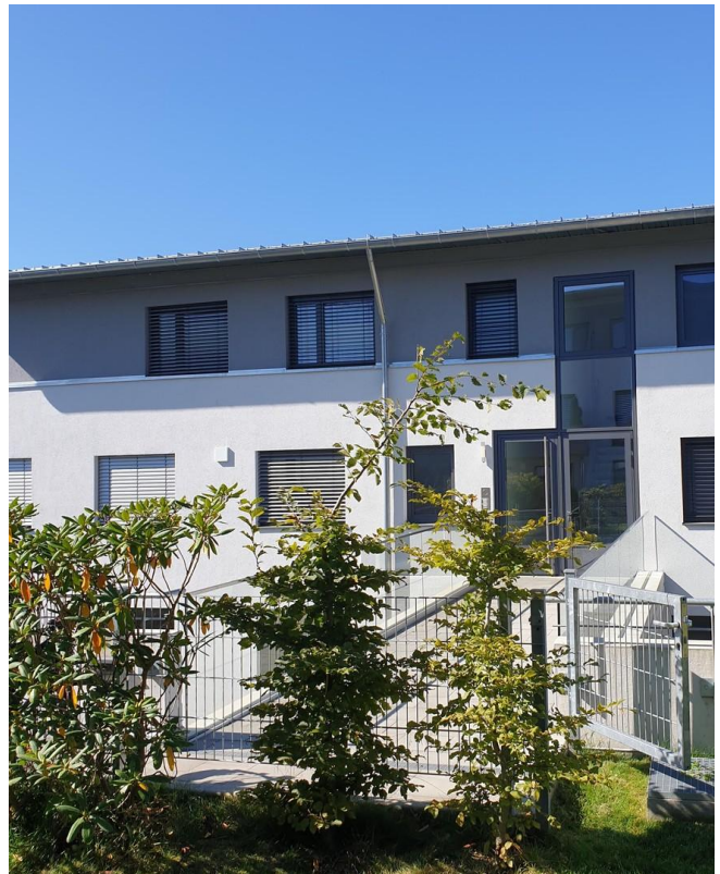
Ostfassade mit Brücke
