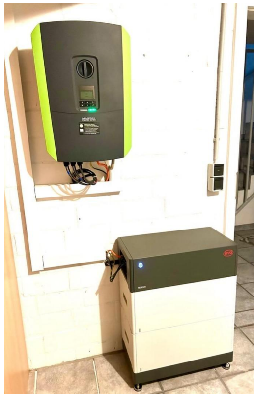
Wechselrichter, Stromspeicher
